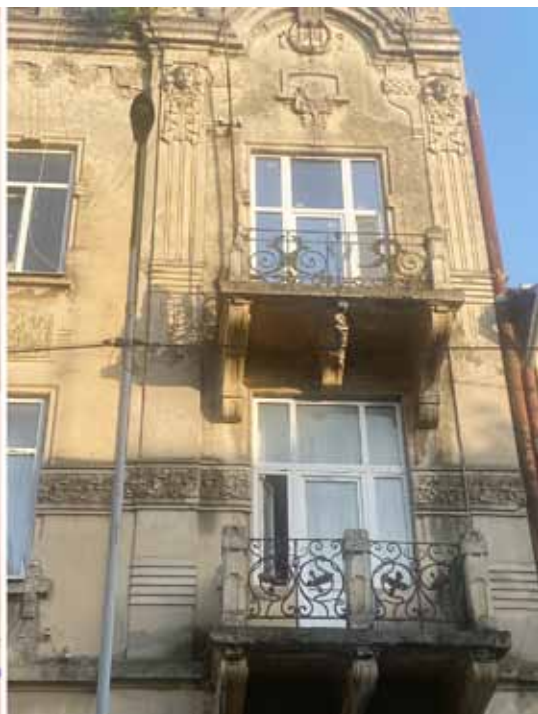
Rys. 6. Fragment elewacji kamienicy czynszowej Pochoreckiego, 2025 r.
