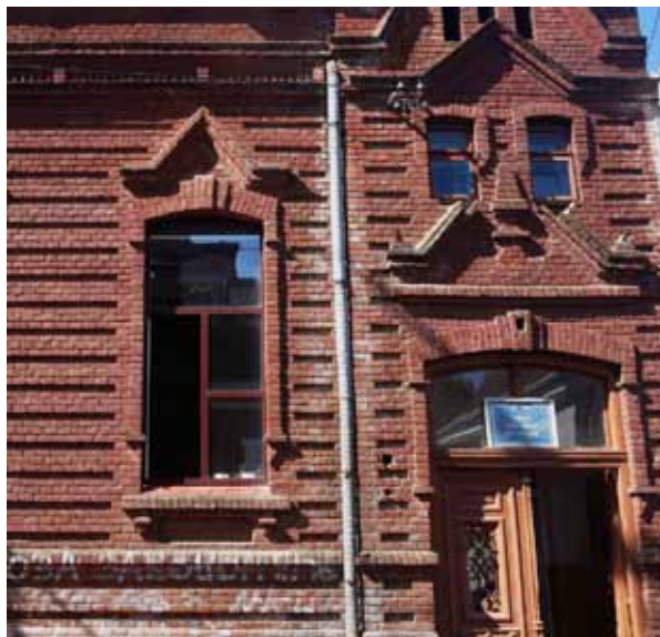
Rys. 3. Fragment elewacji „Czytelnicy Kolejowej” (obecnie – szkoła sportowa), 2025 r. Źródło: ze zbiorów Daniela Hryńkiewicza
