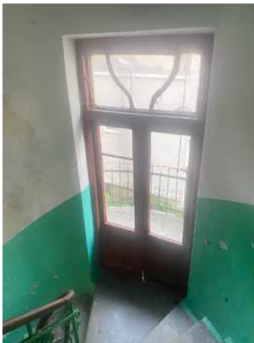
Rys. 7. Secesyjne drzwi balkonowe od strony wewnętrznego dziedzińca
