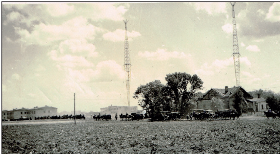
Maszty stacji radiowej w Łucku
