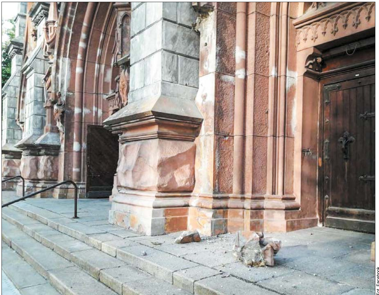
Kościół św. Mikołaja wymaga podjęcia natychmiastowych prac konserwatorskich, by zahamować proces degradacji zabytku
