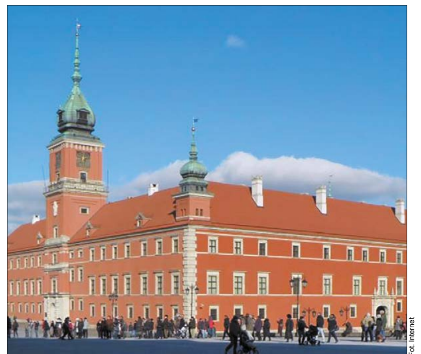
Umieszczenie miniaturowego obiektu „Zamek Warszawski” jest planowane na rogu ulic Zamościańskiej i Strzeleckiej
