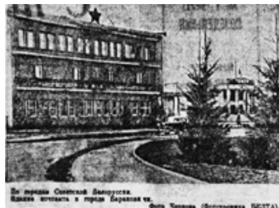
Budynek w okresie okupacji sowieckiej
