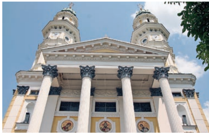
Fasada pojezuickiego kościoła w Użhorodzie
