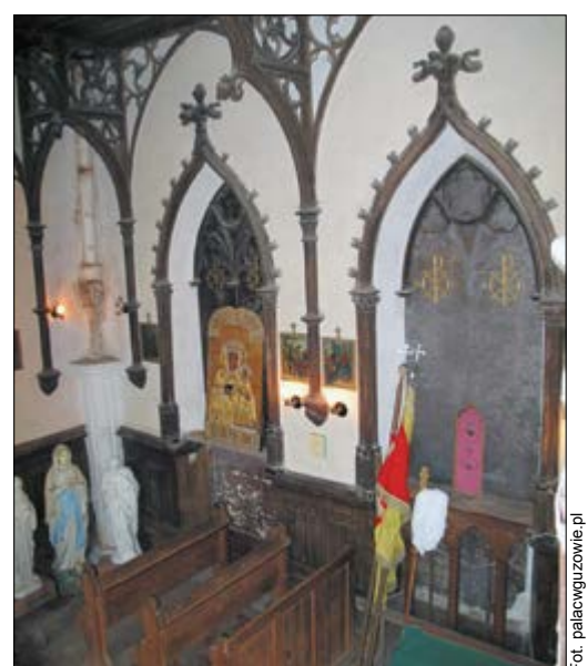
Michał Sobański przeprowadził gruntowny remont kaplicy w Czeczelniku w latach 2014 – 2017
