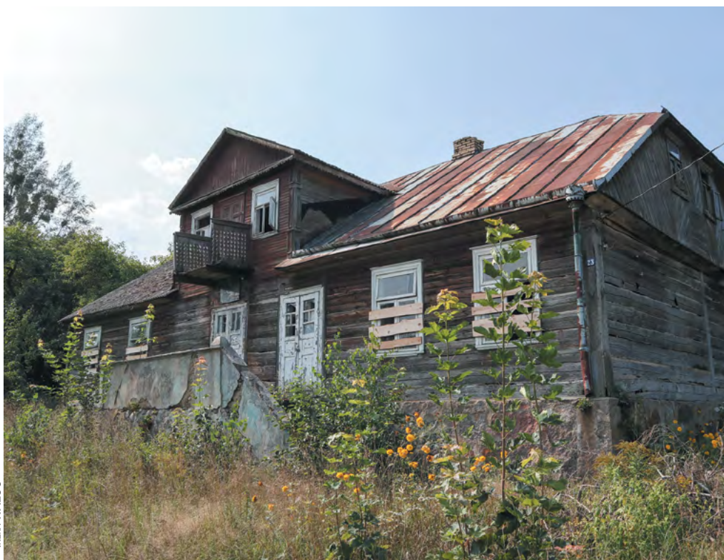
BUDYNEK BYLEJ SZKOŁY W DORGUNIU
