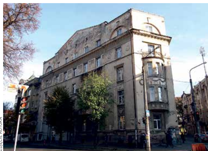
KAMIENICA NA UL. GRUNWALDZKIEJ
