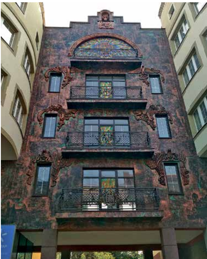
MIEDZIANY BUDYNEK, WIDOK PANORAMICZNY
