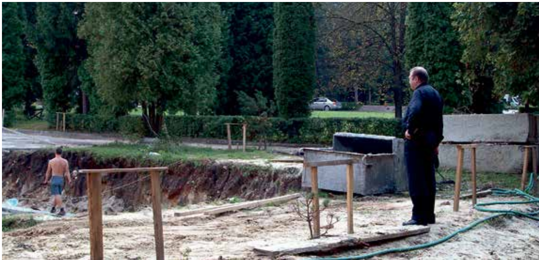
W CZASIE NADZORU BUDOWY NOWEJ BIBLIOTEKI I BUDYNKU DYDAKTYCZNEGO SEMINARIUM DUCHOWNEGO
