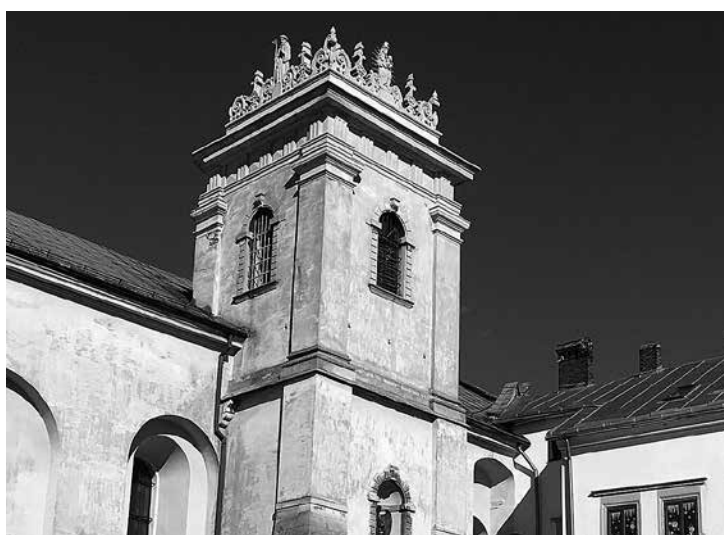
WIEŻA-DZWONNICA KLASZTORU BENEDYKTYNEK
