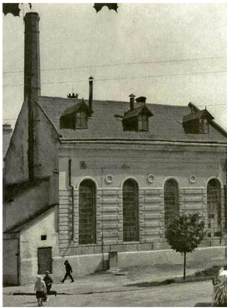
NA BUDYNKU BROWARU BYŁA DATA 1767
