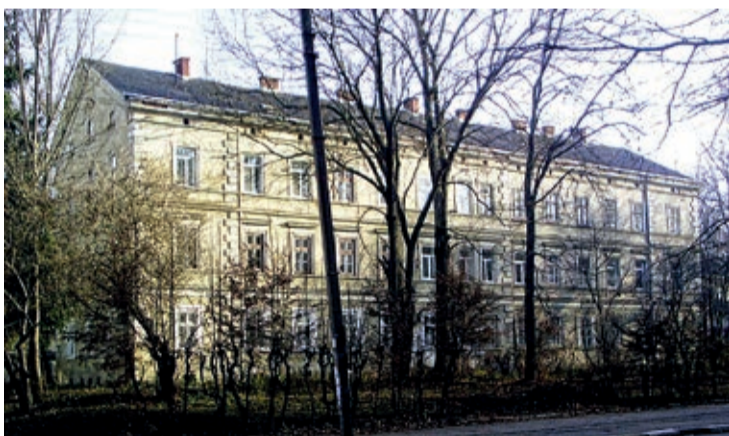
TO TU ZMIENIANO DACH
