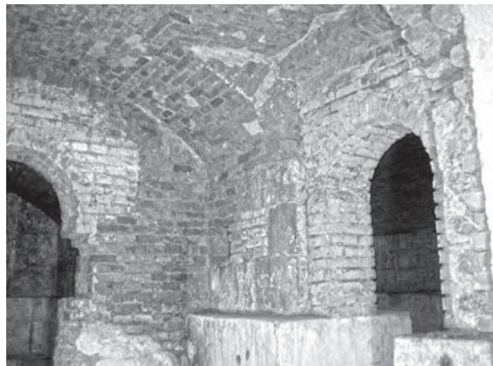
PODZIEMIA RATUSZA, STAN OBECNY
