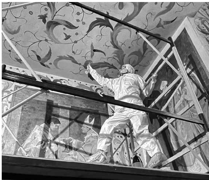
PRACE KONSERWATORSKIE W KAPLICY SEMINARIJNEJ
