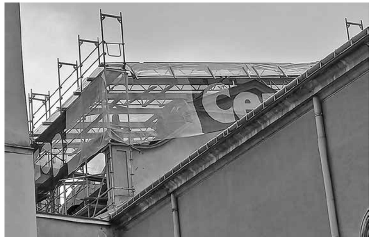
REMONT DACHU KATEDRY ORMIAŃSKIEJ
