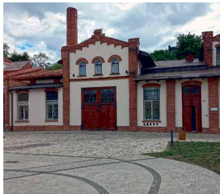
BUDYNEK DAWNEJ ELEKTROWNI
