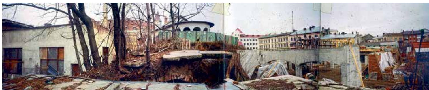
PANORAMA BUDOWY GALERII „BASTION”
