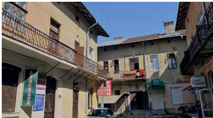
PODWÓRKO KAMIENICY NA MAJDANIE
