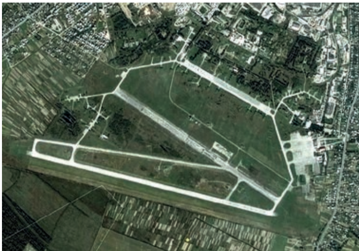
ZDJĘCIE FRANKIWSKIEGO LOTNISKA Z LOTU PTAKA
