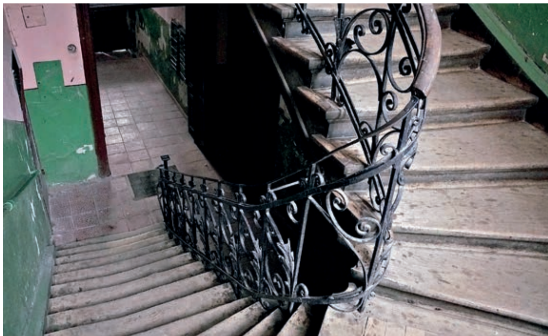
KLATKA SCHODOWA W BUDYNKU PRZY UL. ŁYŻCZAKOWSKIEJ 55
