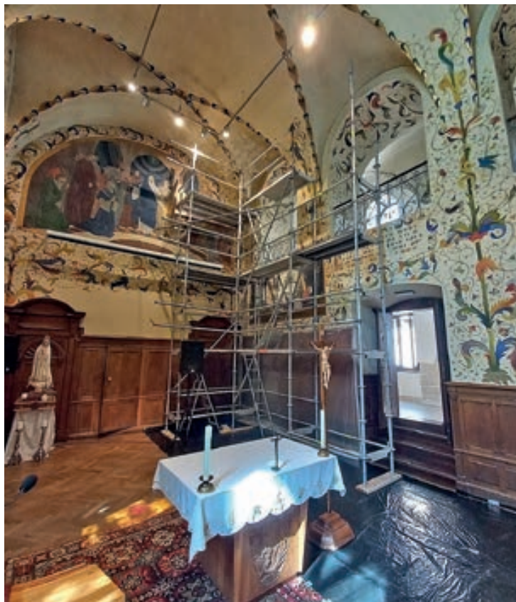
OGÓLNY WIDOK „KAPLICY ROSENA”
