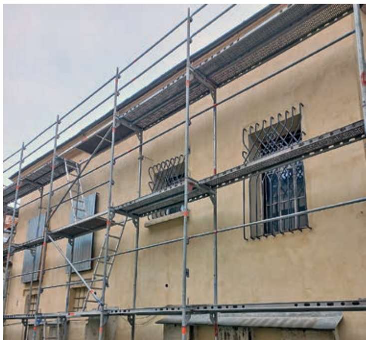
REMONT DACHU KAPLICY
