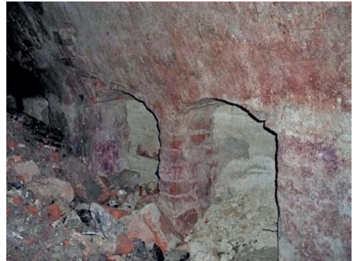
OBMUROWANY KORYTARZ PODZIEMNY, ODSŁONIĘTY PODCZAS PRAC W 2008 R.
