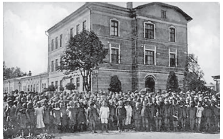
NIEMIECKA SZKOŁA, ZBUDOWANA Z INICJATYWY I WSPARCIA RODZINY ZOKLERÓW. OBECNE LICEUM NR 11
