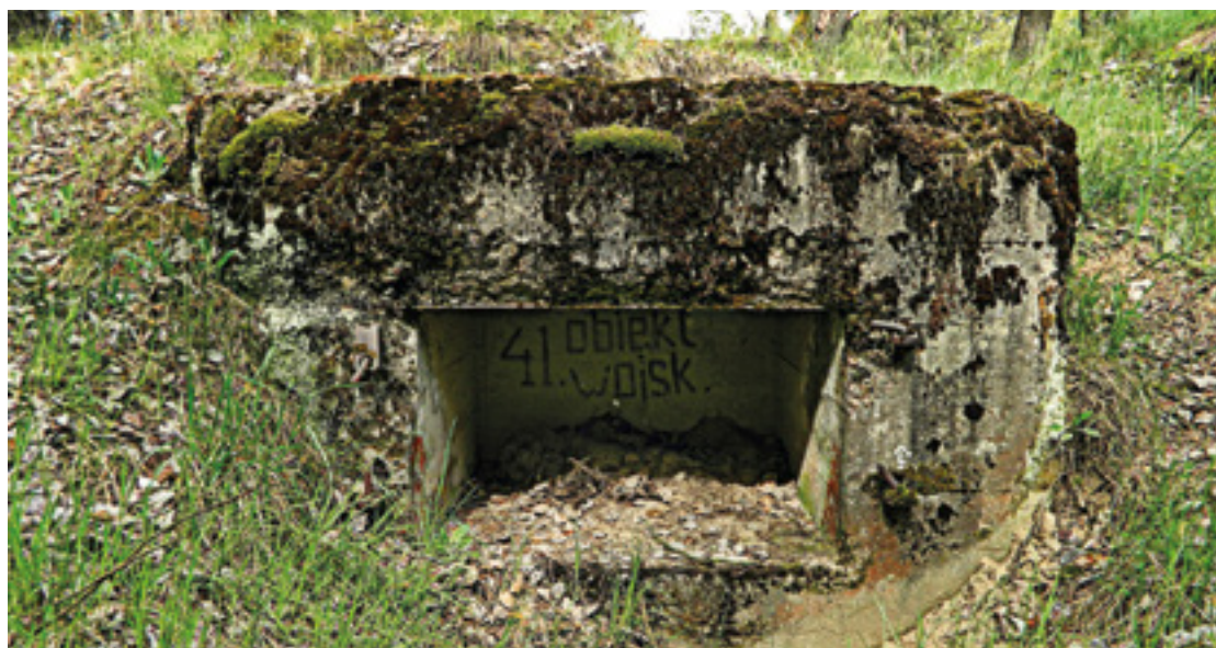
«41 Obiekt Wojsk». Napis na jednej z zachowanych konstrukcji betonowych.
