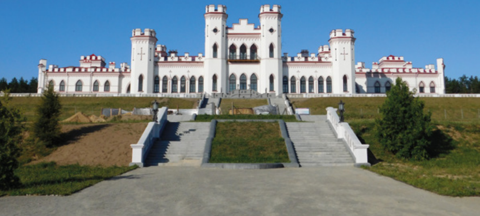
Pałac w Kosowie. Wygląd po renowacji.
