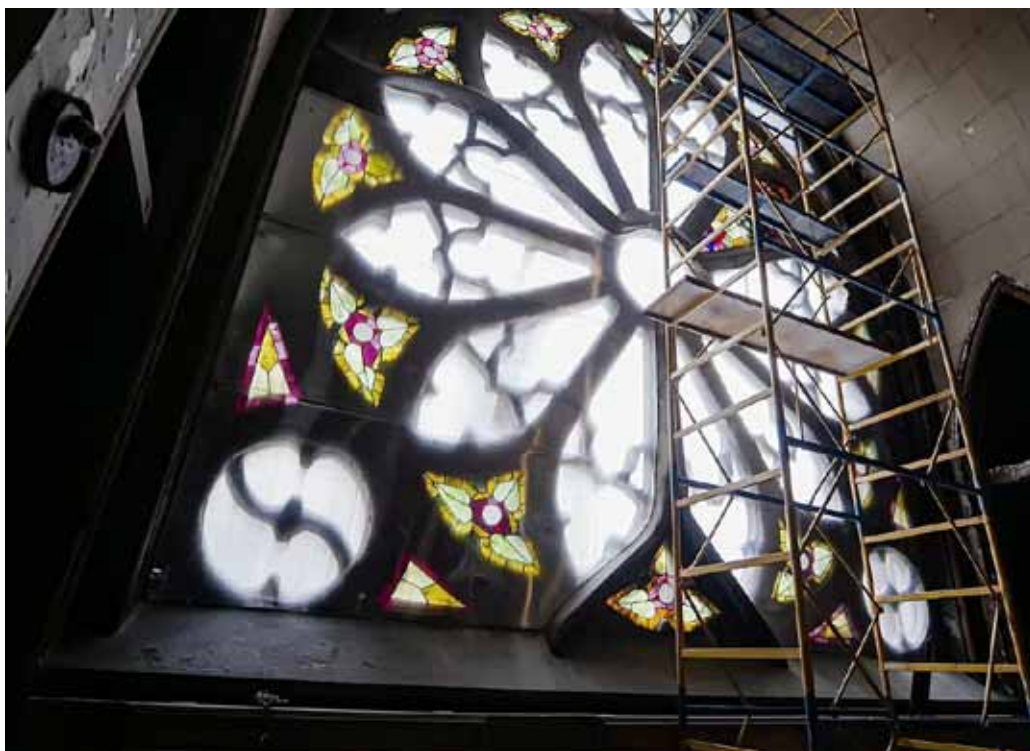
Kościół św. Mikołaja w Kijowie. Rok 2024. Róża – duży okrągły witraż nad głównym wejściem, który został bardzo uszkodzony falą uderzeniową rosyjskiej rakiety
