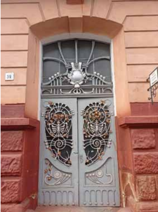
Rys. 6. Brama wjazdowa wykonana w odlewni Wehrsteina kamienicy Falka, 2022 r.
