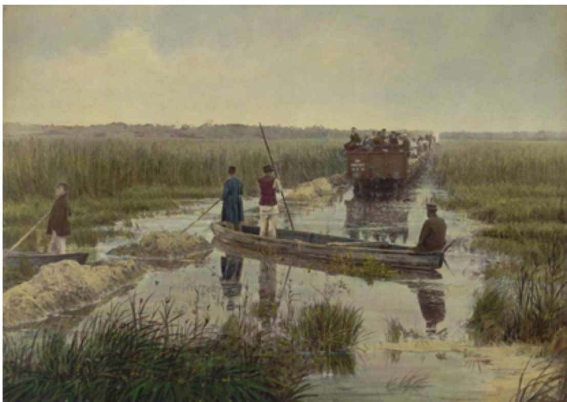
Wileńsko-Rówieńska kolej. Zakład robót ziemskich w dolinie rzeki Prypeci w wiorście 313. na linii kolejowej. Dzisiaj to zdjęcie jest eksponowane na dworcu kolejowym w Łunińcu.
