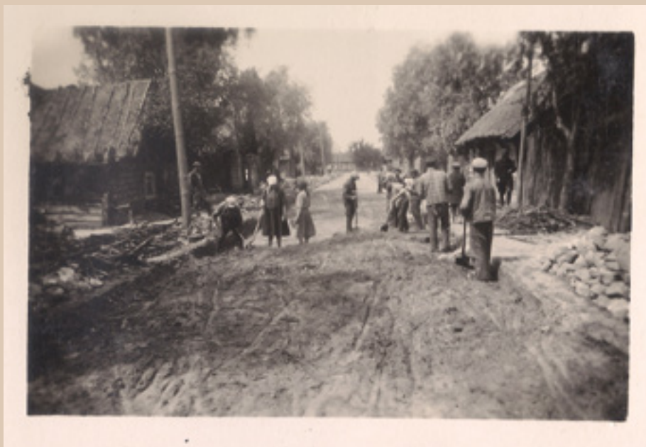
Budowa drogi przez miejscowość na Polesiu. Z archiwum Aleksandra Kirczuka
