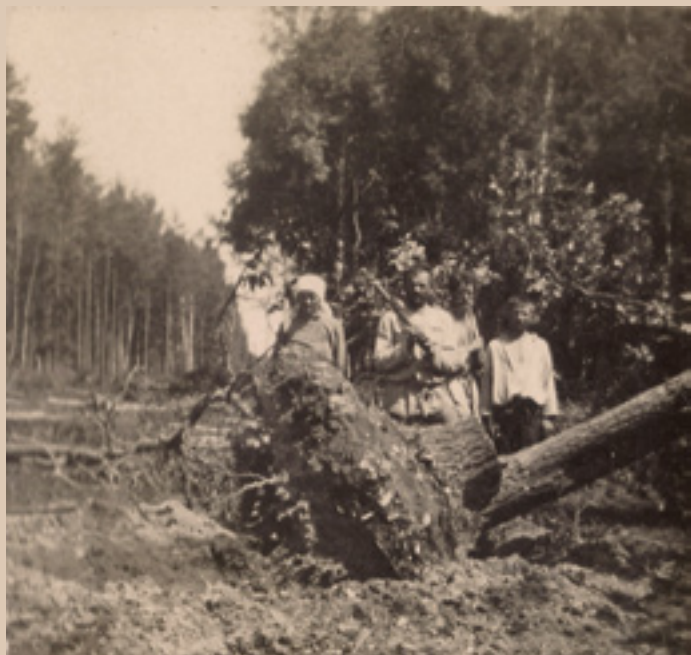
Budowa dróg na Polesiu. Z archiwum rodzinnego Aleksandra Kirczuka.
