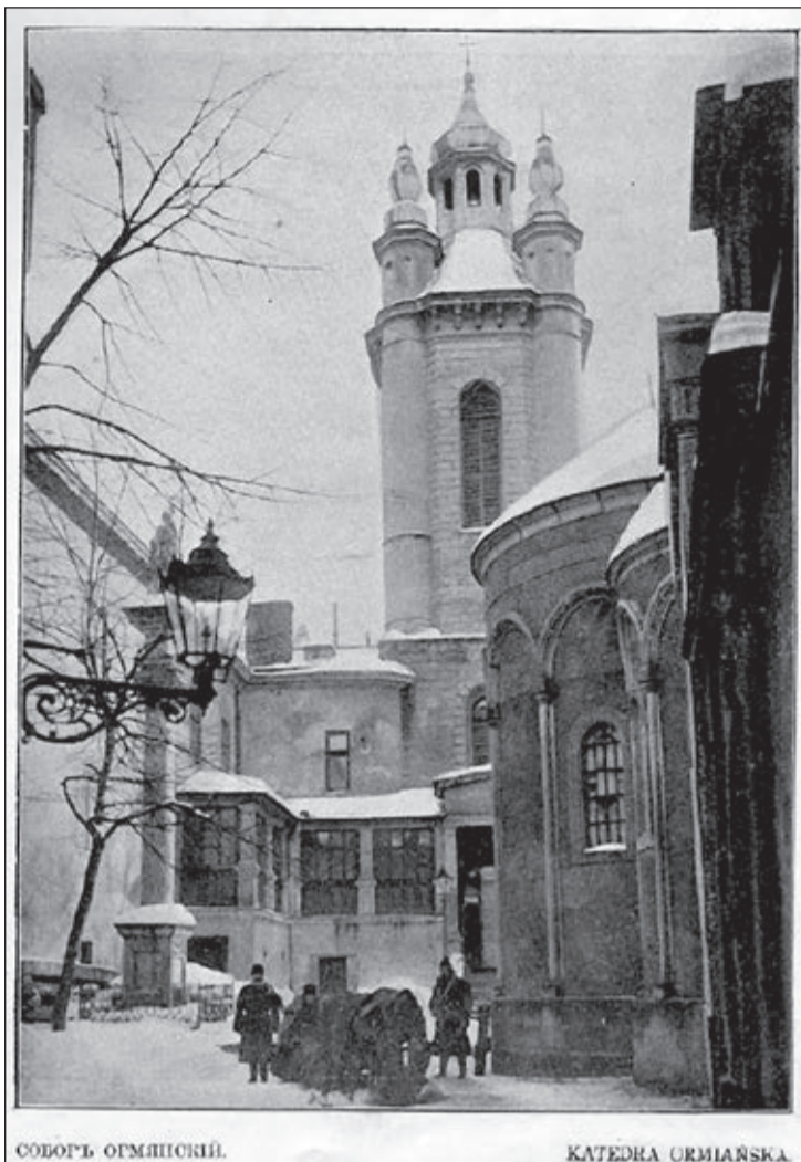
WIDOK PODWÓRKA WSCHODNIEGO Z DZWONNICA POCZ. XX W.
