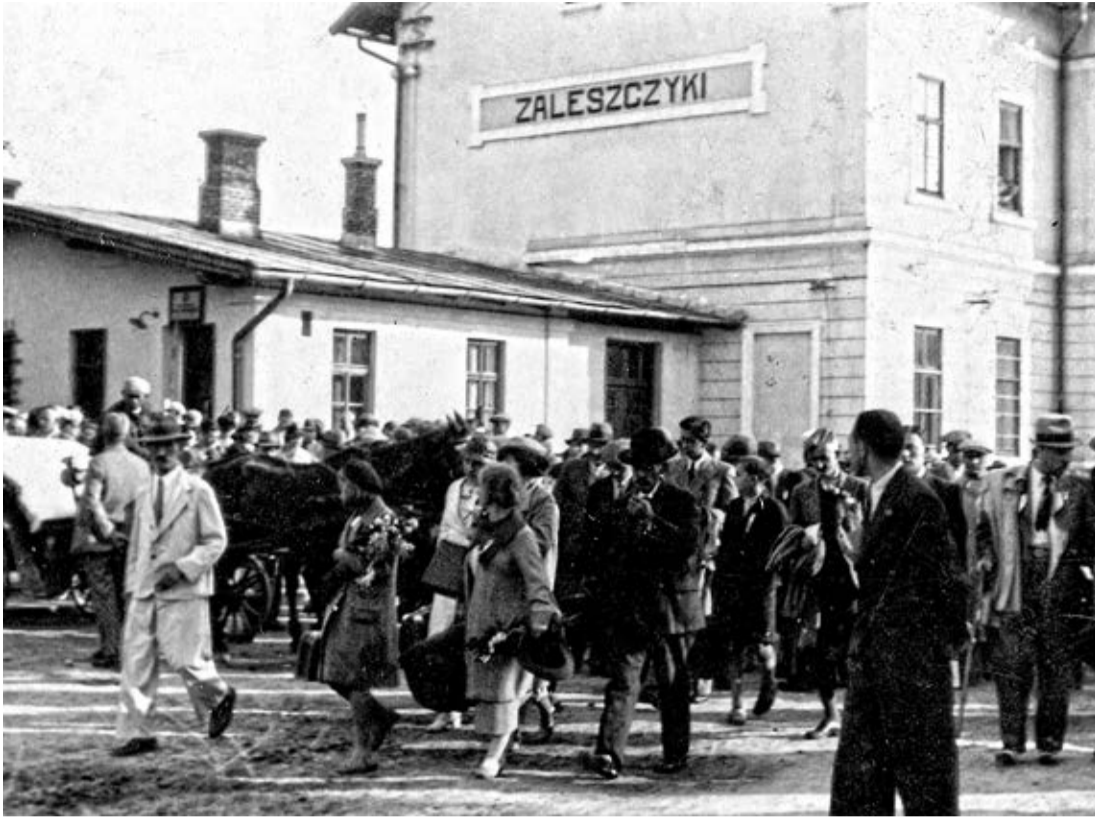
STACJA KOLEJOWA W ZALESZCZYKACH – LATA MIĘDZYWOJENNE
