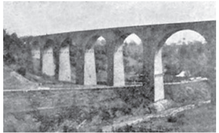
ODBUDOWA WIADUKTU KOLEJOWEGO NA LINII STANISŁAWÓW-WORONIENKA
