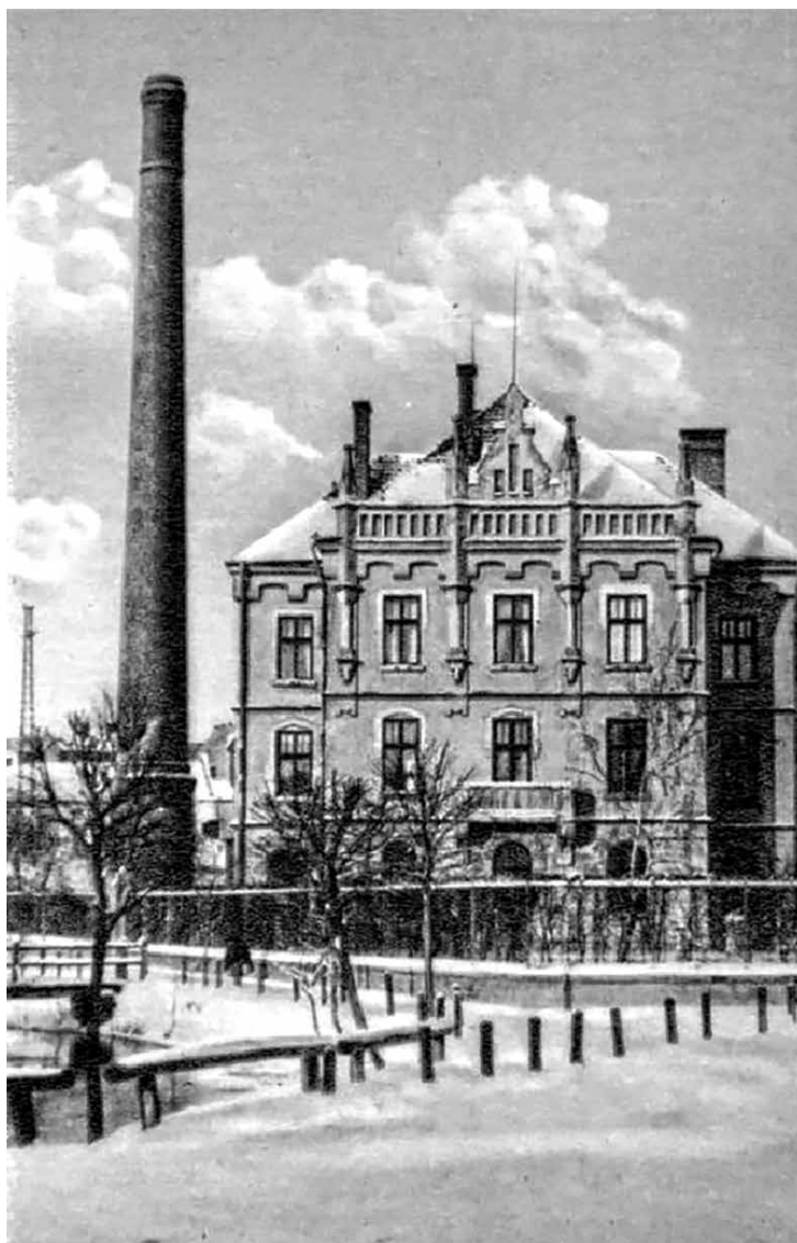
ELEKTROWNIA W SAMBORZE, O KTÓREJ WSPOMINA ALEKSANDER KUCZERA. ZACHOWANA DO DZIŚ
