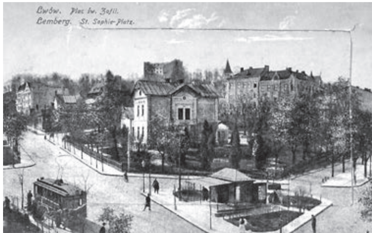
SZKOŁA ŚW. ZOFII (PÓŹNIEJ SZKOŁA SPECJALNA ŚW. KAZIMIERZA) – BUDYNEK WIDOCZNY CENTRALNIE, SKRZYŻOWANIE ULIC ŚW. ZOFII I PUŁASKIEGO
