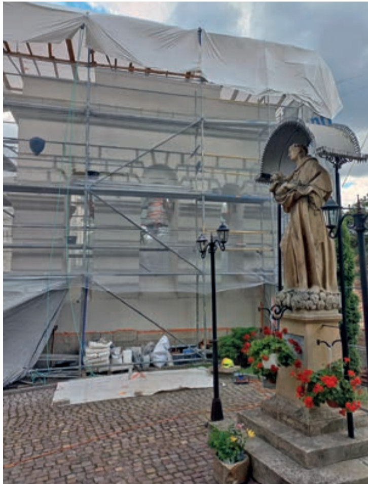
REMONT DZWONNICZY PRZY KOŚCIELE ŚW. ANTONIEGO
