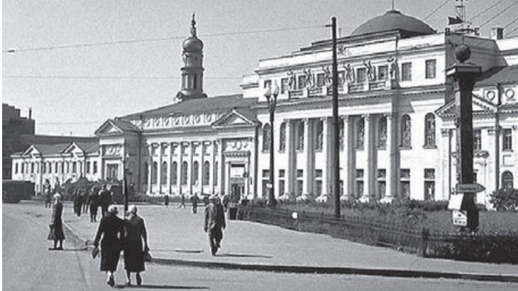
Pałac Pionierów, gdzie po 1917 roku po raz pierwszy została ustanowiona choinka. Budynek się nie zachował
