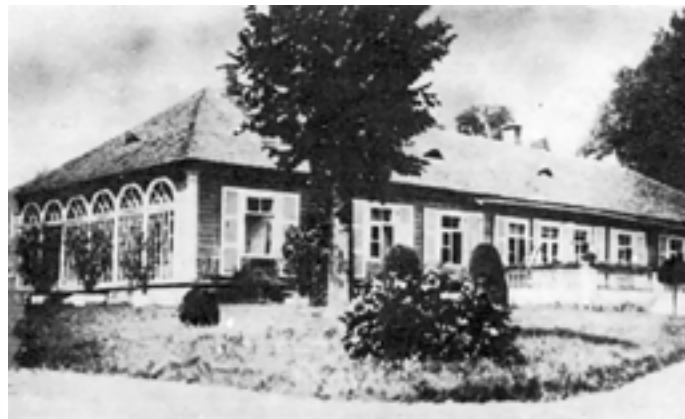
Dwór w Atteczyźnie. Widok od strony ogrodu przed 1939 r. Duży salon przylegał do ogrodu zimowego, zajmującego całą szerokość domu i oświetlonego ogromnymi, półkoliście zamkniętymi oknami. // Aftanazy R, Dzieje Rezydencji na dawnych kresach Rzeczypospolitej , Tom 2, Zakład Narodowy im. Ossolińskich 1997, s. 11
