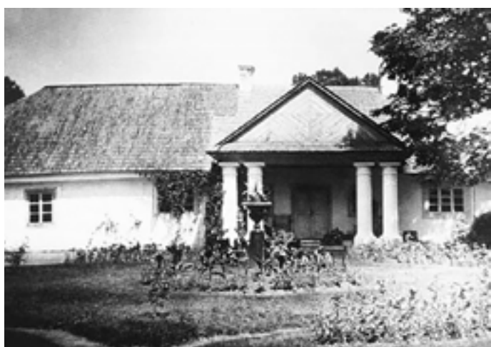
Dwór w Socha. Widok od strony zajazdu przed 1937 r. Ganek o dwóch szeroko rozstawionych parach kolumn murowanych i otynkowanych, wspierających trójkątny szczyt. // www.radzima.org z dnia 01.01.2018
