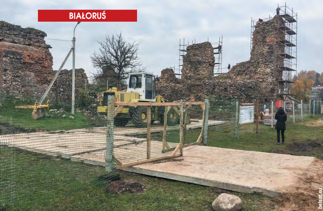
PRACE REKONSTRUKCYJNE MURÓW ZAMKOWYCH
