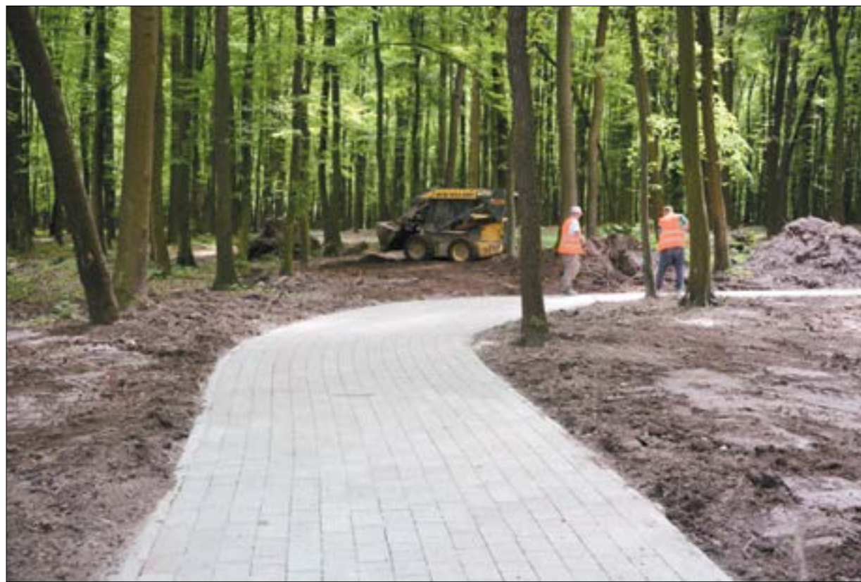
Obecnie w parku imienia Jana Pawła II we Lwowie trwają prace odwadniające teren i montowane są schody
