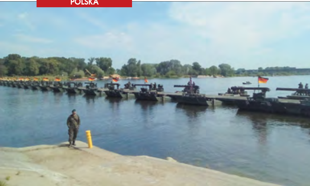
PRZEPRAWA PONTONOWA PRZEZ WISŁĘ W TORUNIU
