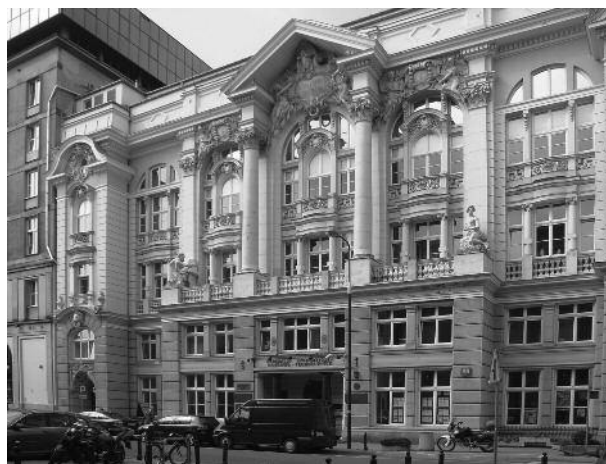
Gmach Domu Technika NOT przy ul. Czackiego w Warszawie
