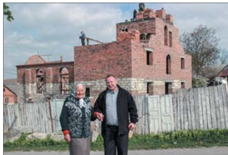
W ostatnich dwóch latach budowa nowego kościoła znacznie przyspieszyła
