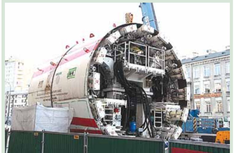
TBM na terenie budowy
