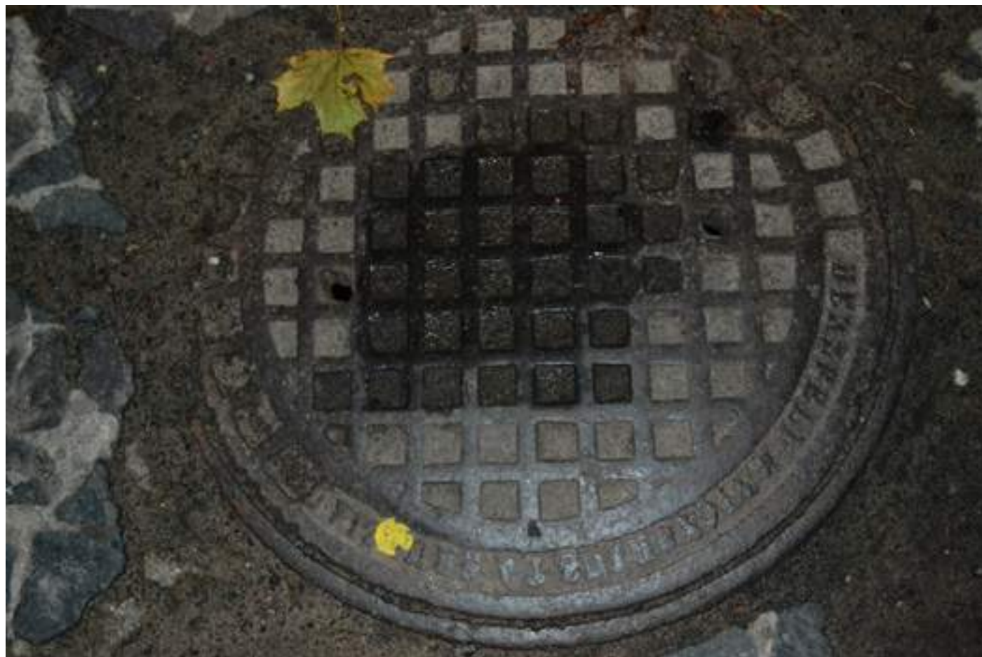
Przedwojenny właz kanalizacyjny w Twierdzy Brzeskiej
