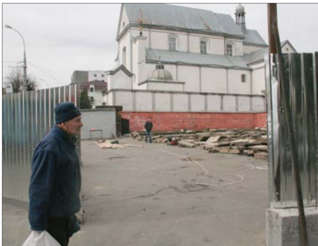
Centrum Winnicy powoli zmienia się w duże centrum handlowe. Tym razem władze miasta zezwoliły na budowę w bezpośredniej bliskości 265-letniego kościoła Kapucynów nowej galerii. Według projektu ma mieć kilka podziemnych kondygnacji. Wykopanie odpowiednio głębokiego wykopu może grozić zawaleniem kościoła
