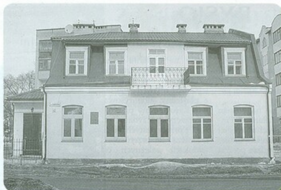
Dom Ryszarda Kapuścińskiego przy ul. Błotnej
