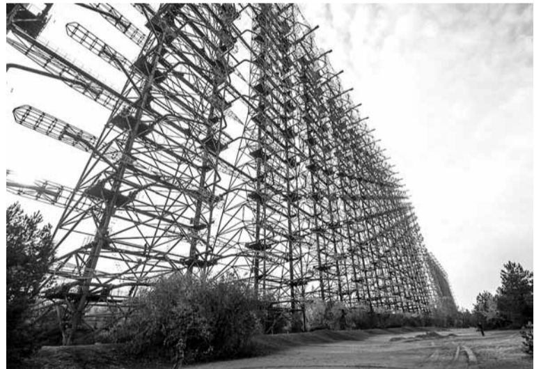
„Дуга” (nazywana „Oknem Moskwy” lub „Rosyjskim Dziecięciem”) - dziś atrakcja turystyczna znajdująca się nieopodal Czarnobyla to nieużywana obecnie instalacja radzieckiego strategicznego radaru pozahoryzontalnego (OTH). Służyła do wykrywania nadlatujących pocisków balistycznych m.in. z USA z głowicami nuklearnymi, jako jeden z ważnych elementów systemu wczesnego ostrzegania
