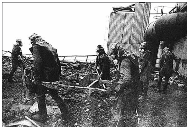
Zdjęcie likwidatorów pracujących w strefie silnego skażenia. Jasne smugi w dolnej części fotografii są efektem silnego promieniowania.
