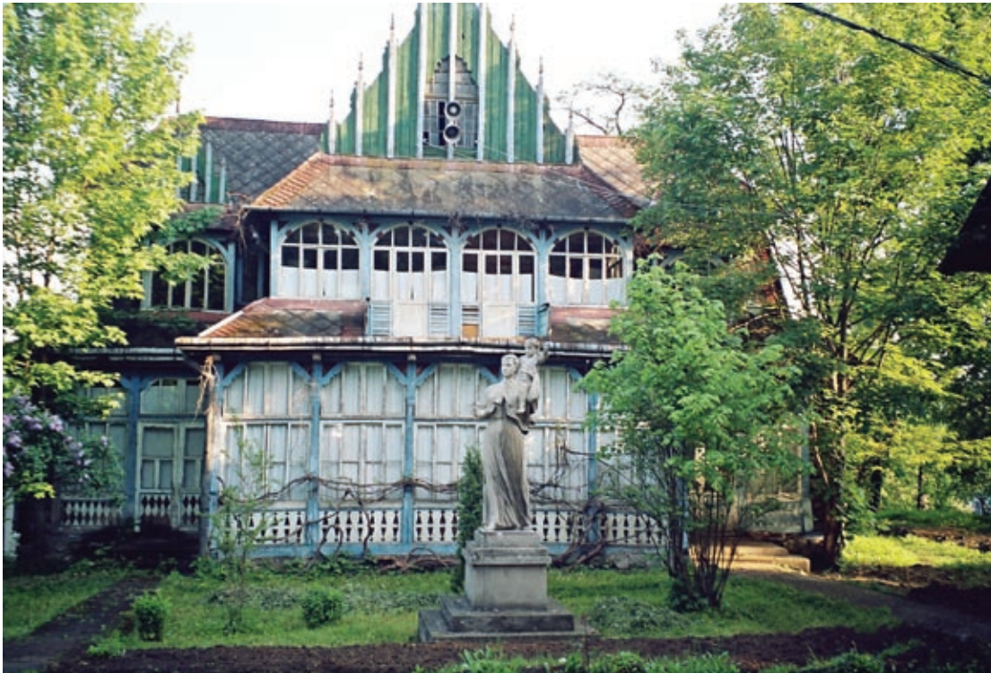
Budynek starego sanatorium
