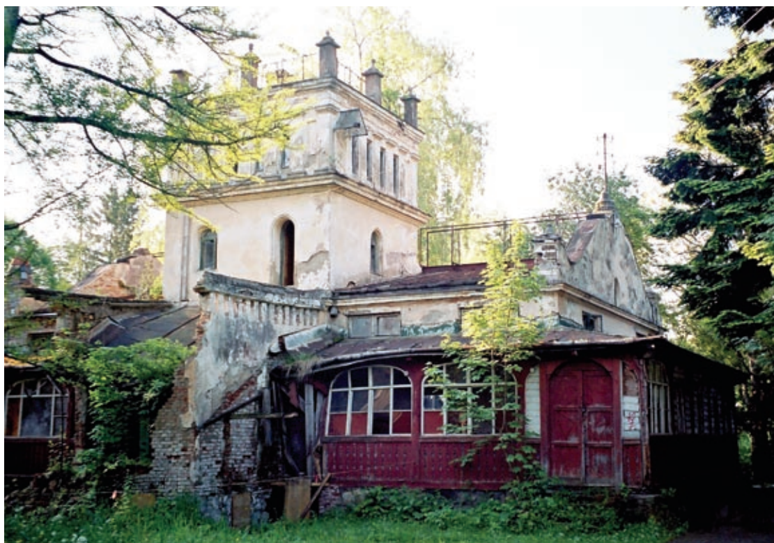
Budynek starej łaźni popada w ruinę
