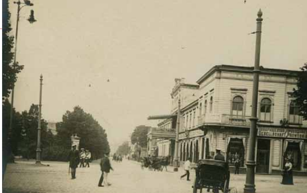
W tym budynku przy ul. Elizabetes 55 szkoła A. Jastrzębskiej mieściła się do 1910 r. Widok od strony ul. Aleksandra, gdzie było wejście do pensjonatu szkoły (z archiwum Łotewskiej Biblioteki Narodowej)
