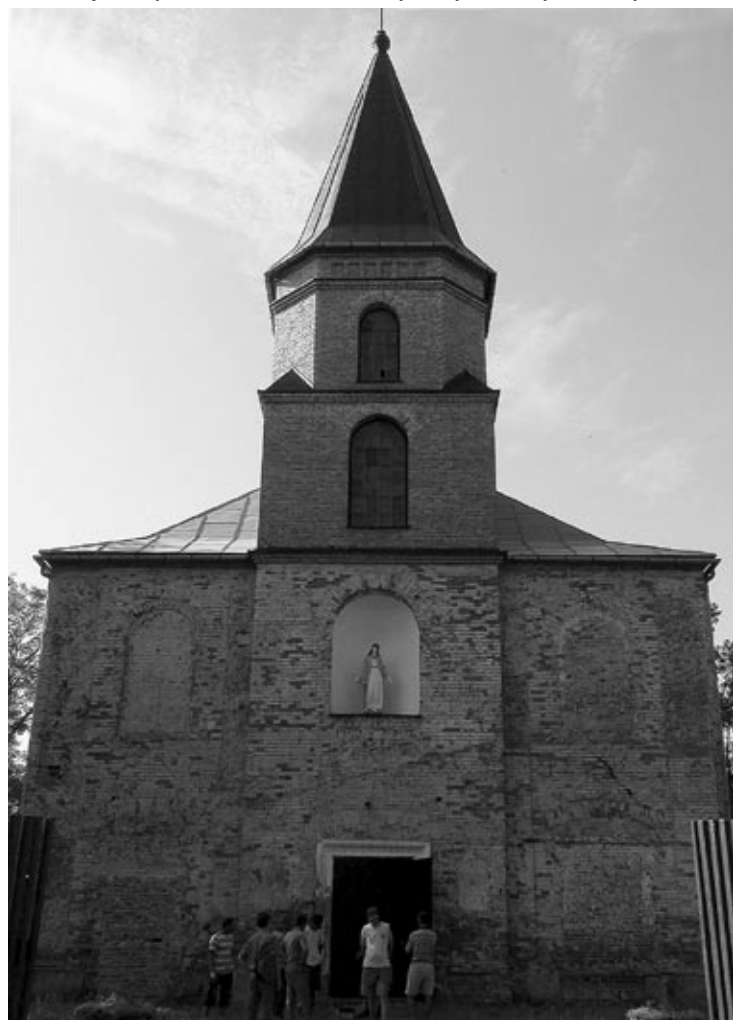
Kościół przed remontem
