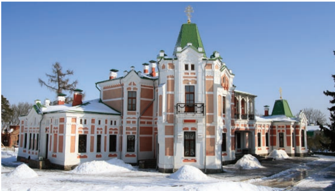
Dwór Chojeckich w Tomaszówce (stan obecny)
