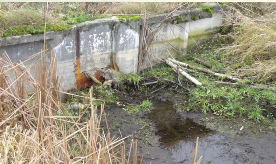
„odpowiedź bobrów meliorantom” – zatkana rura, łącząca kanał z tamą z kanałem głównym
